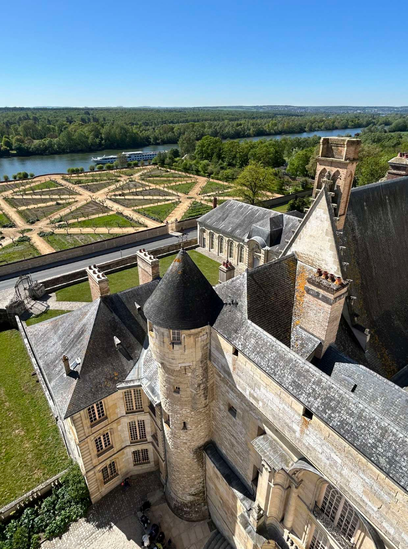
Vue partielle du Château de La Roche-Guyon • ©e.morin
